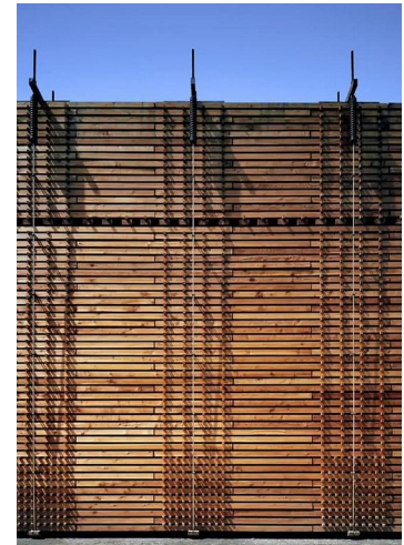
Abbildung 3.6 Vorgespannte Stapelwände des Expo-Pavillons [27]
